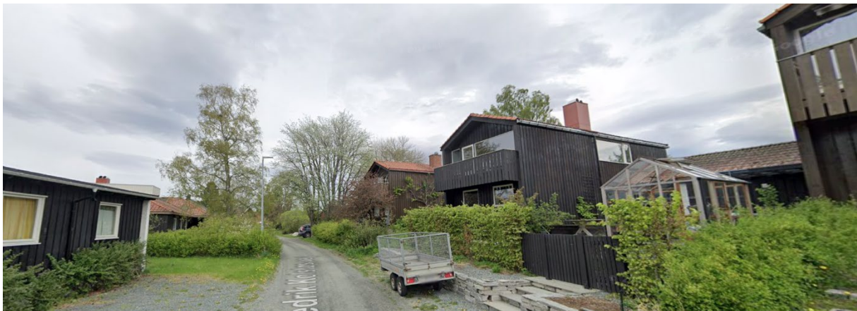
Fig. 24: Nordligste atrium-boliger med hageside mot Fredrik Kolstøs veg til høyre.
